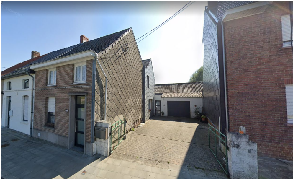
Foto 1 : overbouwing van de buurtweg 212 thv woningen Stookstraat 307-311 (bron: Google-Maps)
