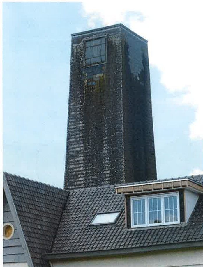
Foto 4: zicht op de schutterstoren vanuit het oosten. Het raam met venster in de oostzijde van de top is bewaard. Het dichtgemaakte raam in de noordzijde van de top is nog afleesbaar aan de minder verkleurde leien (plaatsbezoek Onroerend Erfgoed 26.07.2023).
