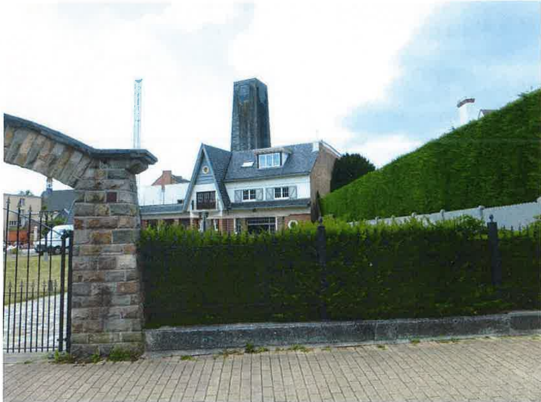
Foto 3: zicht op de schutterstoren vanuit het oosten (Sint-Pietersnieuwstraat). Het raam met venster in de oostzijde van de top is bewaard. Het dichtgemaakte raam in de noordzijde van de top is nog afleesbaar aan de minder verkleurde leien (plaatsbezoek Onroerend Erfgoed 26.07.2023).
